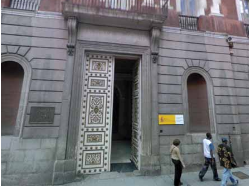
Fachada de la sede del Consejo Escolar del Estado.
